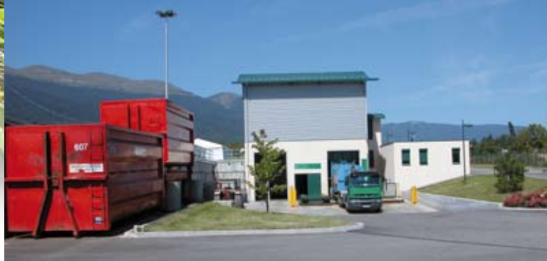
Le quai de transfert
